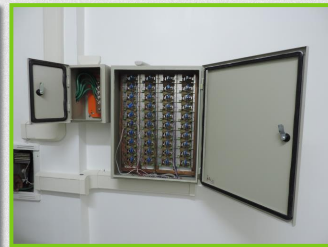
Troca completa dos Quadros de Energia internos e Instalação de Malha de Aterramento
