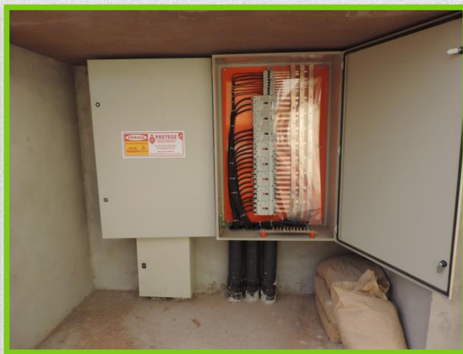
Troca completa do Quadro de Força/Painel de Comando
