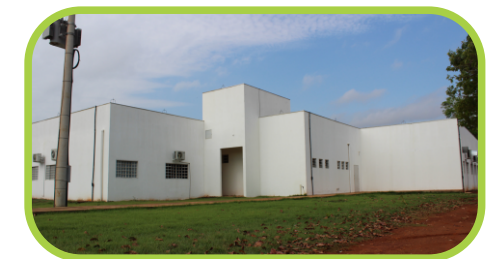
O prédio abriga pesquisas de diversas áreas.
